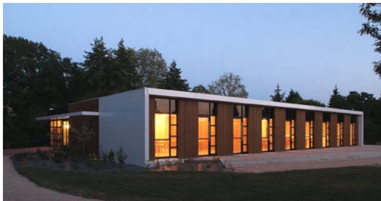
Exemple de traitement : petit volume, bâtiment préfabriqué.
