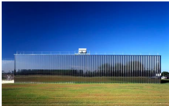
La façade en écailles métalliques en inox, pour sa capacité de composer avec le paysage, en le sublimant. Usine Aplix, Le Cellier, France
