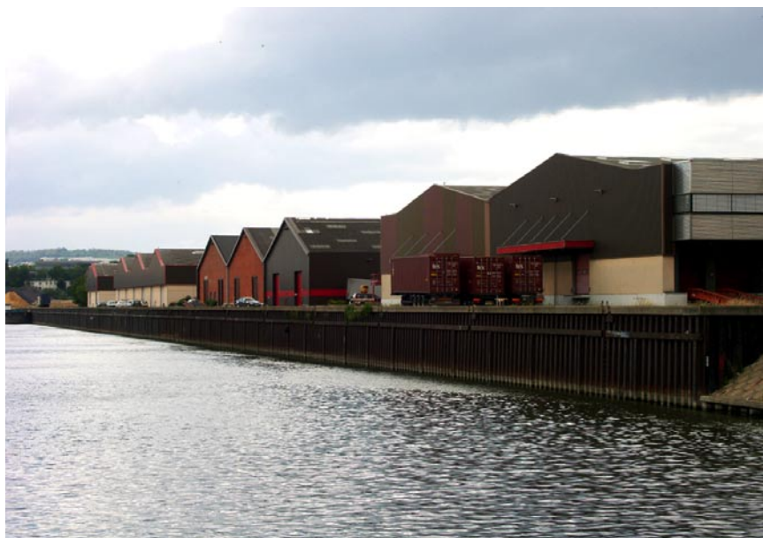
Port de Gennevilliers - Les différents entrepôts composent un ensemble très harmonieux : gabarits, rythmes, couleurs, simplicité du traitement,...
