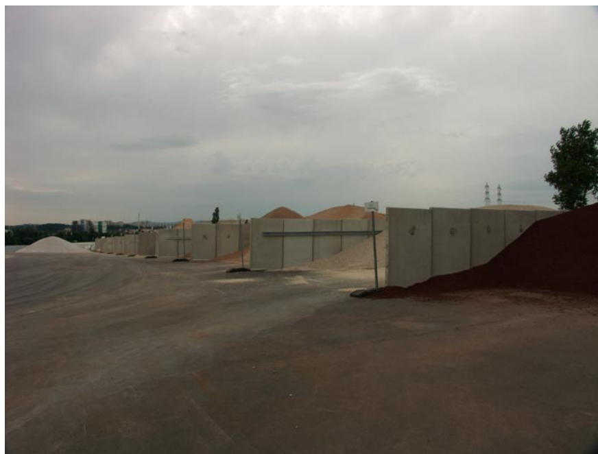
Rue de Sète, Port Edouard Herriot - un espace de stockage bien positionné le long de la limite séparative et bien traité avec des casiers béton.
