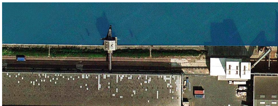
Une bande végétale relie la parcelle à l'eau Port de Gennevilliers
