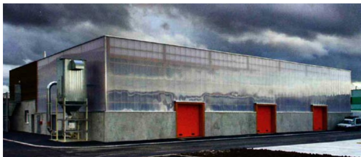
Le contraste obtenu entre le socle en béton brut et le haut de la façade en polycarbonate. Sobriété ponctuée par les entrées colorées. Centre technique à Sevrans, France
