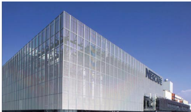
La façade en maille métallique, pour sa légèreté et sa transparence. Usine Nescafé, Orbe, Suisse
