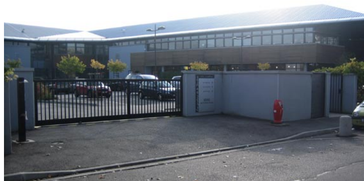
Exemple de traitement de l'accès : ZA La Saulaie
