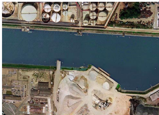
Uniquement le quai de chargement est à traiter en dur Port de Gennevilliers
