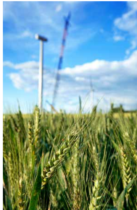
Le parc éolien de La Motte de Galaure, Drôme (26), France.
