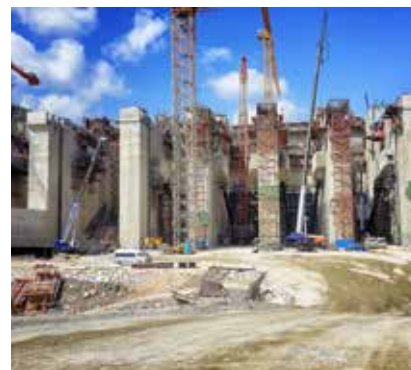
Construction du barrage de Xayaburi.
